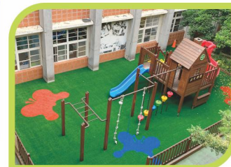
遊具安全鋪面改善後-安全地壁上再加設人工草皮
